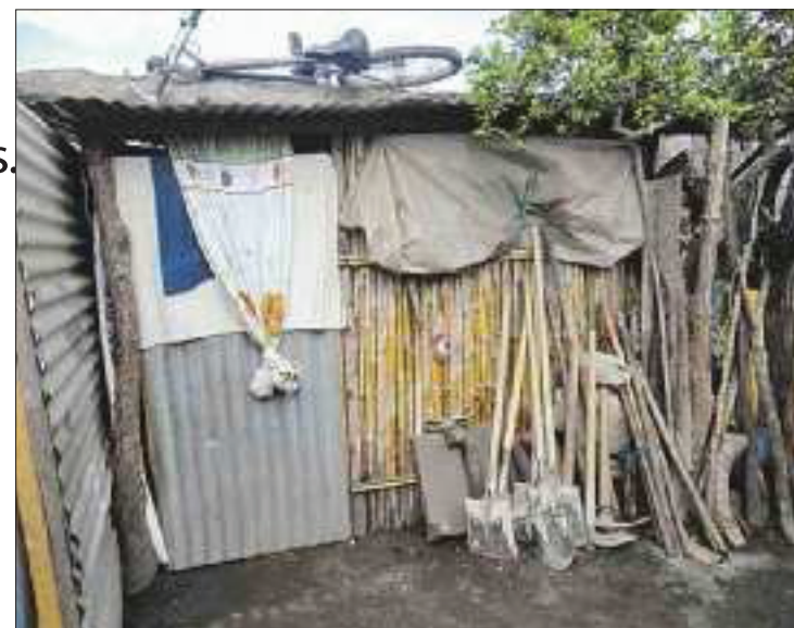
FØR: Slik så det gamle etromshuset til familien ut fra utsiden.
